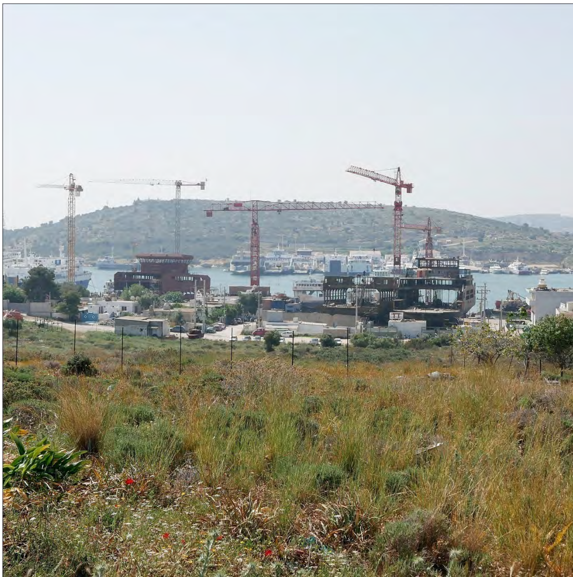
Εικ. 14. Οι εγκαταστάσεις των ναυπηγοεπισκευαστικών εταιρειών στον όρμο Αμπελακίων. Φωτό: Κωνσταντίνος Ζηργάνος-Καζολέας.
