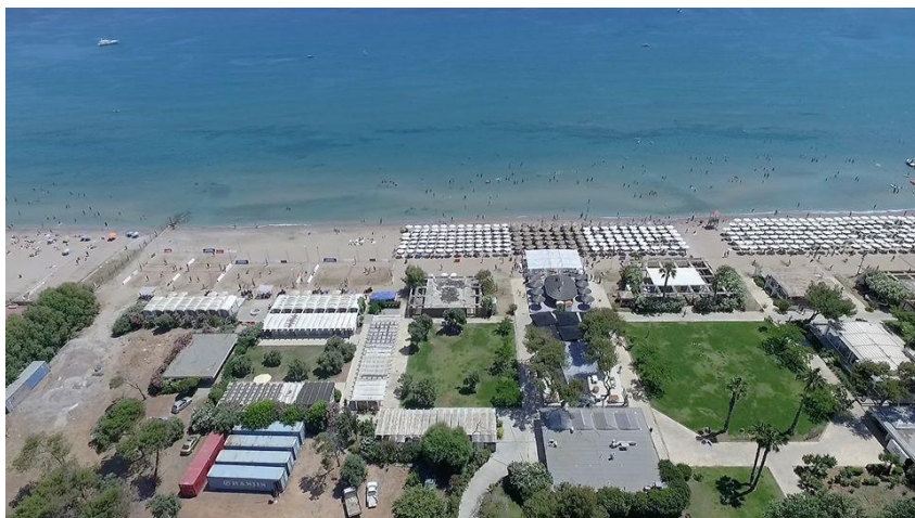
Εικ. 13. Εγκαταστάσεις οργανωμένης πλαζ Βάρκιζας
