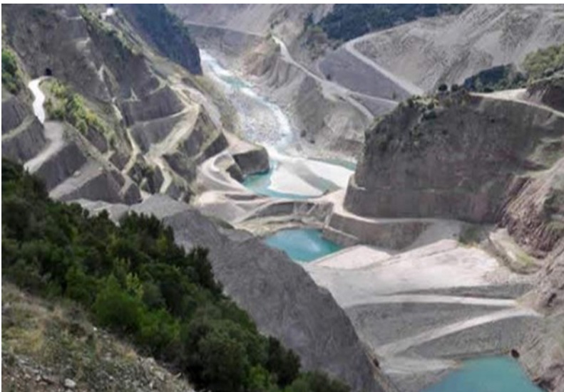
Εικόνα 9: Αρχικό στάδιο κατασκευής
