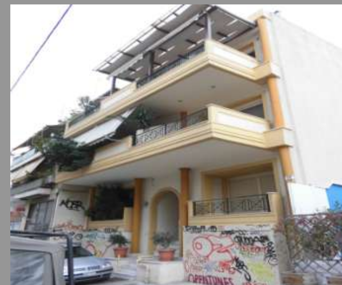
Κτίριο από οπλισμένο σκυρόδεμα
