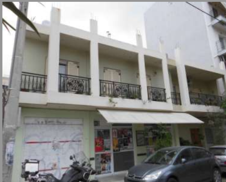
Κτίριο σε μέτρια κατάσταση
