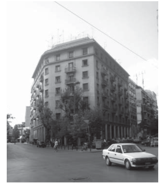
Εικόνα 2,3,4. Δείγματα του ποικιλόμορφου αλλά λανθάνοντος κτιριακού δυναμικού της περιοχής ενδιαφέροντος.
