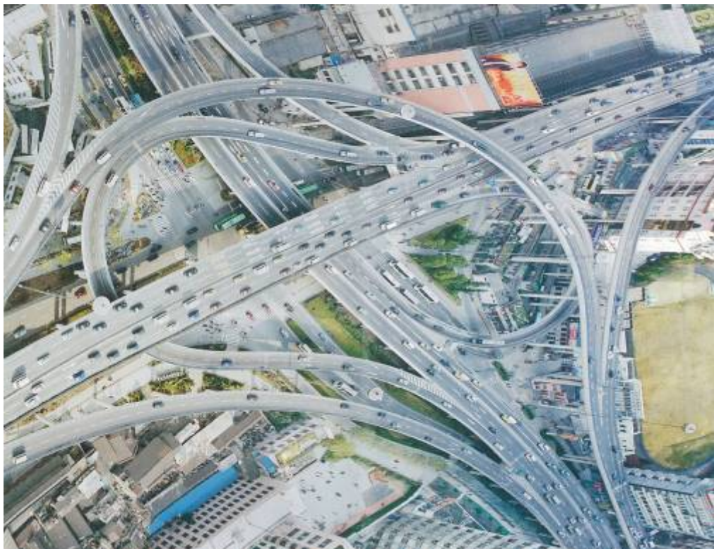
Εικ. 4. κυκλοφοριακός κόμβος στη Σαγκάη 2004. Πηγή: 10 th (V.A.B.)
