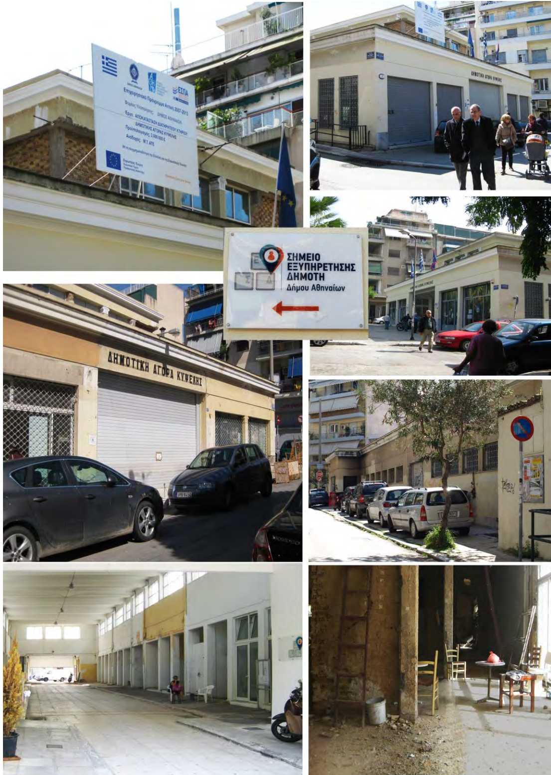
Εικόνες της Δημοτικής Αγοράς σε διαφορετικά χρονικά διαστήματα κατά τη διάρκεια εκπόνησης της διερεύνησης. Επισημαίνεται ότι στο εσωτερικό του κτίσματος εκτελούνται εργασίες αποκατάστασης.
