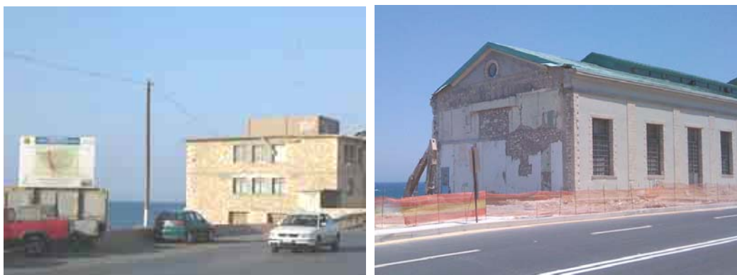
Εικόνες 7, 8 : Το κέντρο κατάρτισης και η παλιά Ηλεκτρική πριν την αποκατάστασή τους με τη νέα χρήση.
