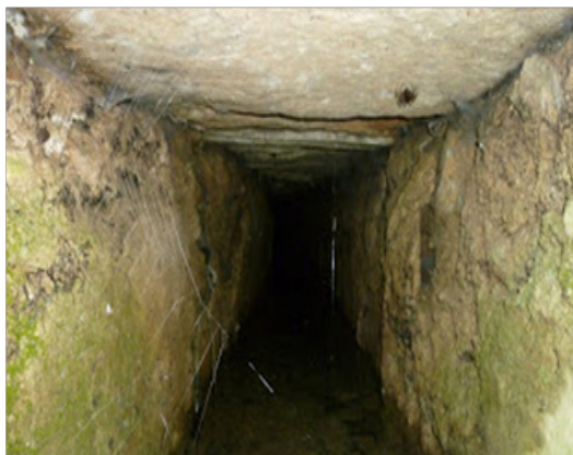
Τμήμα του υπόγειου καναλιού του υδραγωγείου
