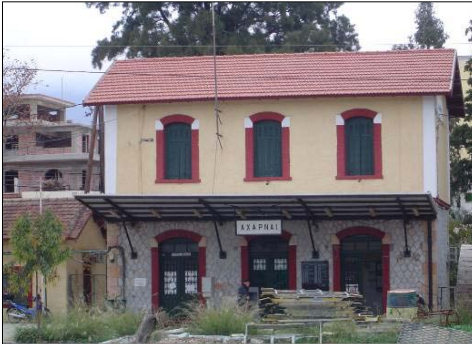
Εικόνα 29 .Το κεντρικό κτήριο του σιδηροδρομικού σταθμού των Αχαρνών (πηγή: προσωπικό αρχείο)
