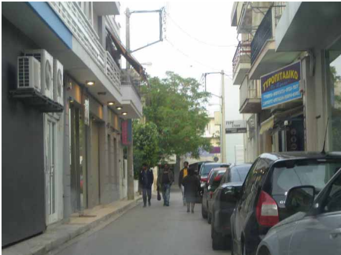
Εικόνα 8: Οι πεζοί αναγκάζονται να περπατούν στο δρόμο λόγω της ανεπάρκειας των πεζοδρομίων. Πηγή: προσωπικό αρχείο
