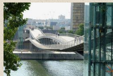
Πεζογέφυρα σύνδεσης της αριστερής όχθης με το πάρκο του Bergy
