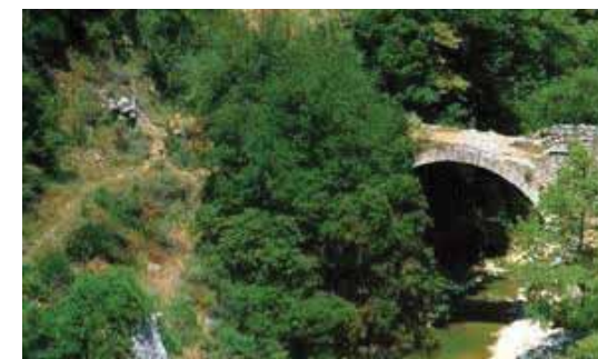
Εικόνα: Πέτρινη Γέφυρα στα Πετράλωνα
