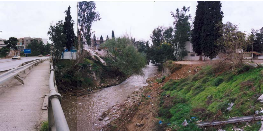
Θέση 2, Τοποθεσία Κόκκινος Μύλος
