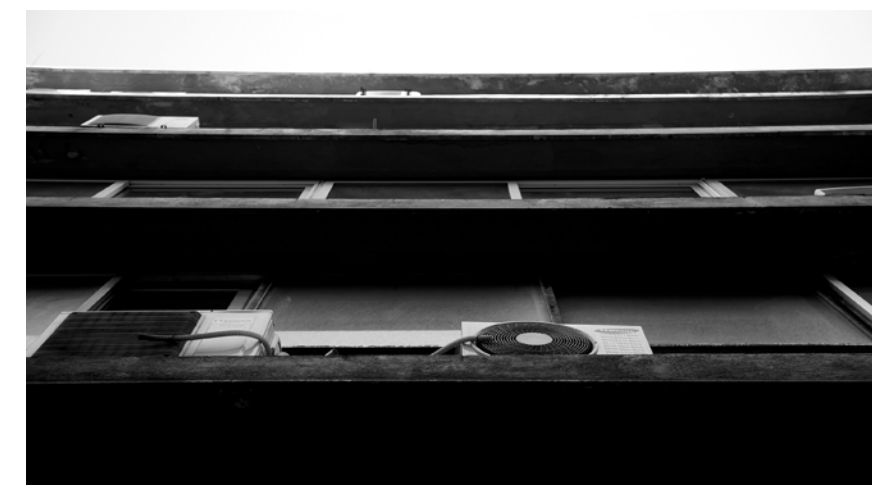
Άποψη τμήματος της όψης από το δρόμο
