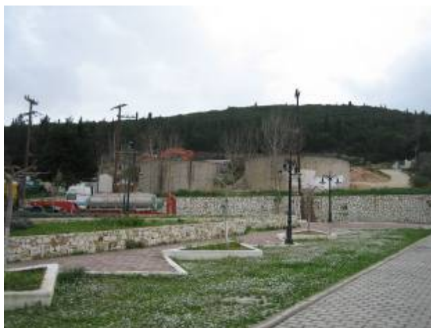
Εικόνα 23. Οι τρεις κυλινδρικές υδατοδεξαμενές και η τσιμεντένια επιφάνεια συλλογής νερού στα δυτικά του οικισμού
