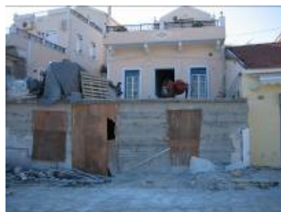
Εικόνα 30. Καταστρατήγηση της υποχρέωσης κατασκευής στέγης – δημιουργία αναβαθμίδων
