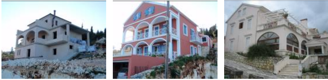
Εικόνα 24. Ογκώδεις οικοδομές στο δρόμο προς το Φώκι
