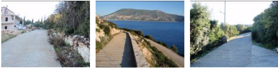
Εικόνες 25. Διανοίξεις τσιμεντοστρωμένων δρόμων – καταστροφή αυτοφυούς βλάστησης
