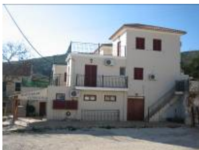
Εικόνα 30. Καταστρατήγηση της υποχρέωσης κατασκευής στέγης – δημιουργία αναβαθμίδων
