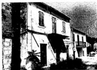
Έργο επισκευής Έργο άσκησης Αρχιτεκτονική μελέτη
