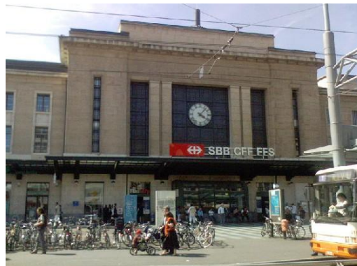
σιδηροδρομικός σταθμός Γενεύης με υπόγειες εμπορικές γαλαρίες, πηγή φωτογραφίας: διαδίκτυο
