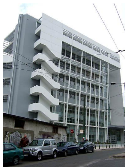
το κτίριο του ΟΠΕΚΕΠΕ επί της Δομοκού
