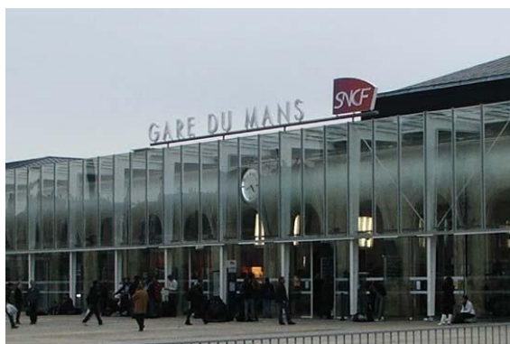
σιδηροδρομικός σταθμός στη Mans, Γαλλία, με ξενοδοχεία, εστιατόρια, τράπεζα, φοιτητική εστία και γραφεία, πηγή φωτογραφίας: διαδίκτυο
