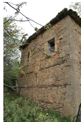
Ιδιαίτερη κατεργασία των γωνιόλιθων του κτηρίου, των ποδιών και των υπέρθυρων.
