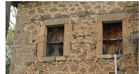
Ιδιαίτερη κατεργασία των γωνιόλιθων του κτηρίου, των ποδιών και των υπέρθυρων.
