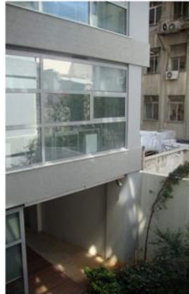
Χυτά υλικά (σοβάς, τσιμεντοκονία) επί φέροντος οργανισμού
