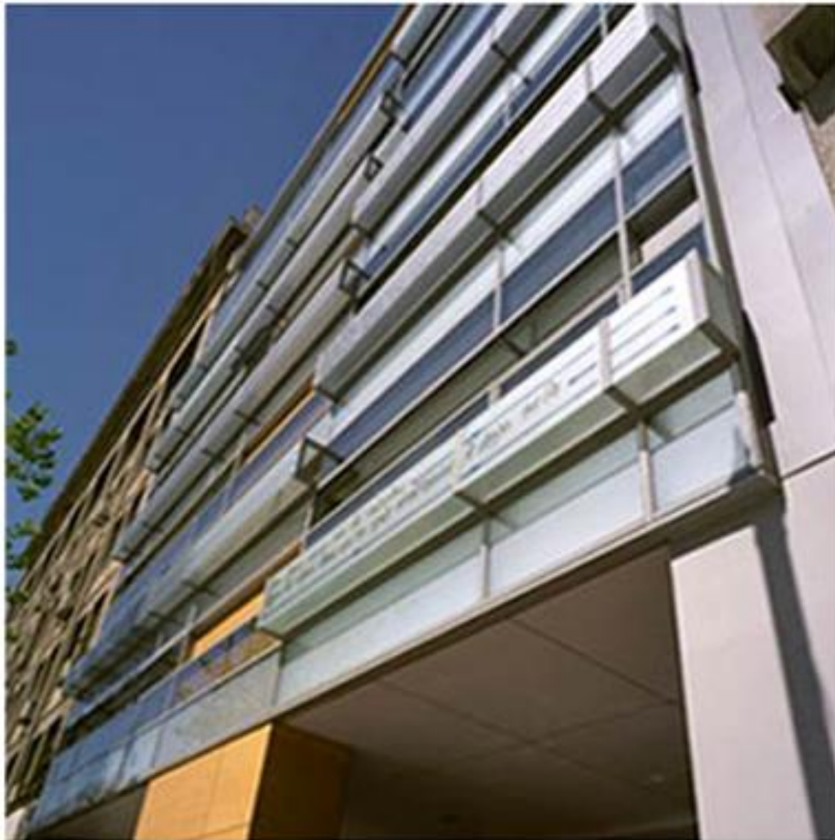
Η όψη επί της Οδού Πειραιώς
