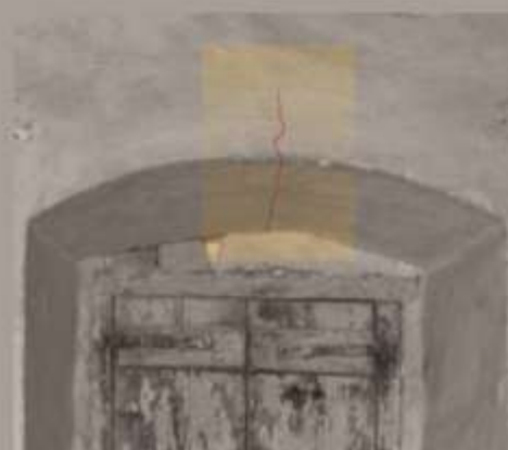
Ρωγή μικρού εύρους στο τοξωτό άνοιγμα στη θέση του κλειδιού.
