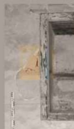
P 22 : Επιφανειακή ρωγή διαβαθμισμένου εύρους στο εξασθενημένο σημείο του εντοιχισμένου εμβριρίου.
