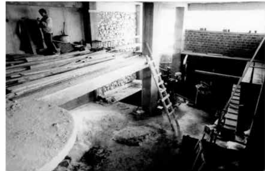
Το κτίριο υπό κατασκευή με την νέα πλάκα παταριού
