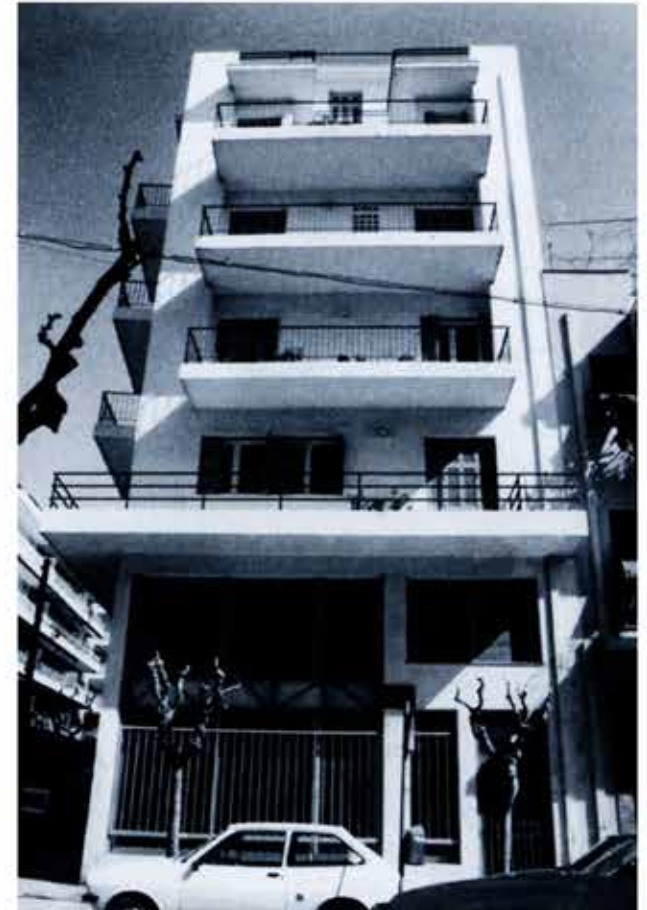
Όψη οδού Μεταξά
