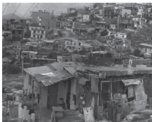
Εικ.4. Άποψη του αυθαίρετου οικισμού το 1974
