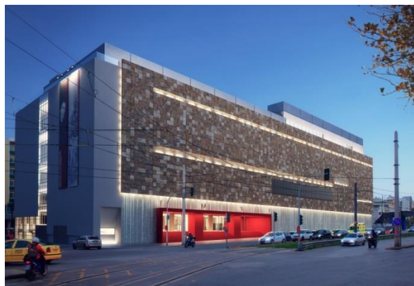
ΕΜΣΤ σήμερα (όψη Καλλιρρόης) Πηγή: http://ayarchitects.com
