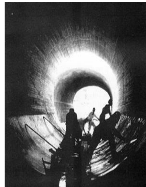
Εικόνα 20: Έργα τσιμεντοποίησης των ρεμάτων
