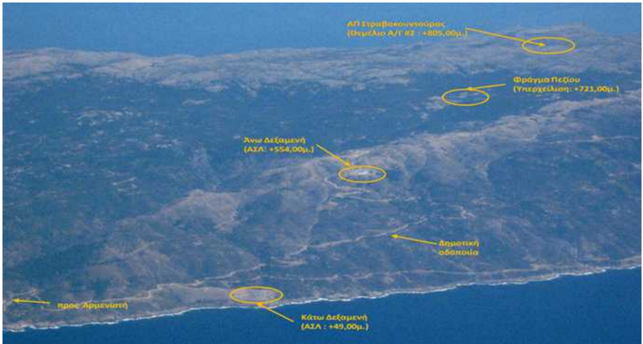
(Εικόνα 5) Αεροφωτογραφία που είναι σημειωμένη η χωροθέτηση των επιμέρους εγκαταστάσεων του υβριδικού συστήματος. Πηγή Ιστοσελίδα samos 24
