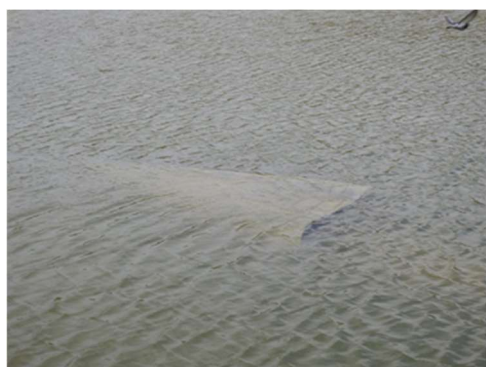
Εικόνα 63 : αποκόλληση τμήματος ρnc Λ. Ναϊάδα
