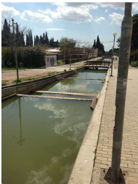
Εικόνα 67 : ποσότητα νερού στο κανάλι (13-03-17)
