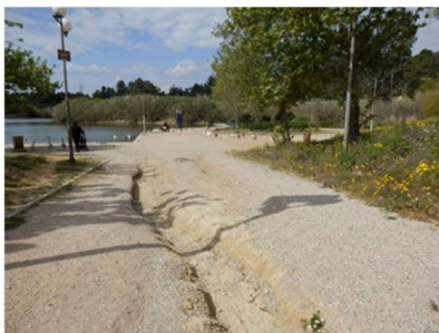
Εικόνα 39 : «νεροφάγωμα» του εδάφους
