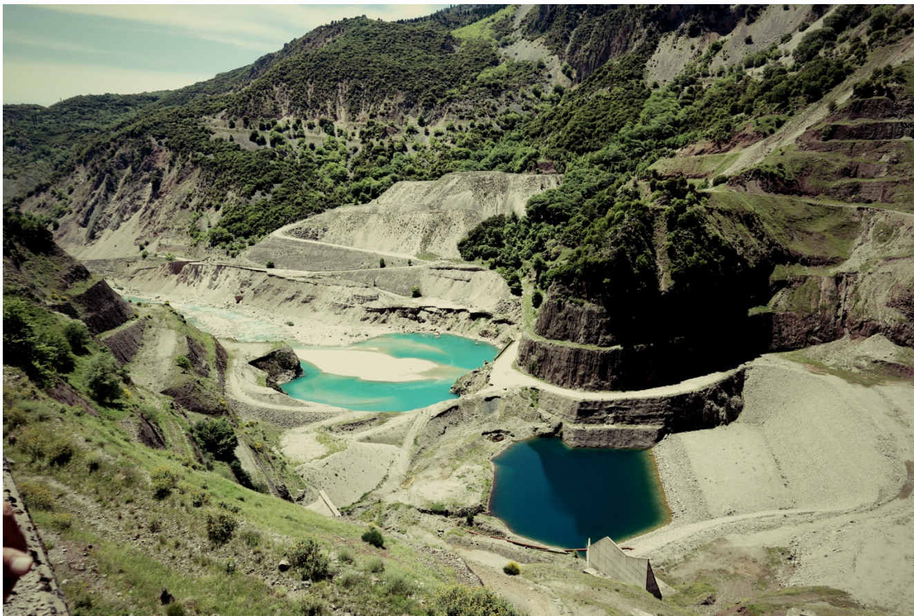
Εικόνα 9: Το υπο κατασκευή φράγμα Συκιάς
