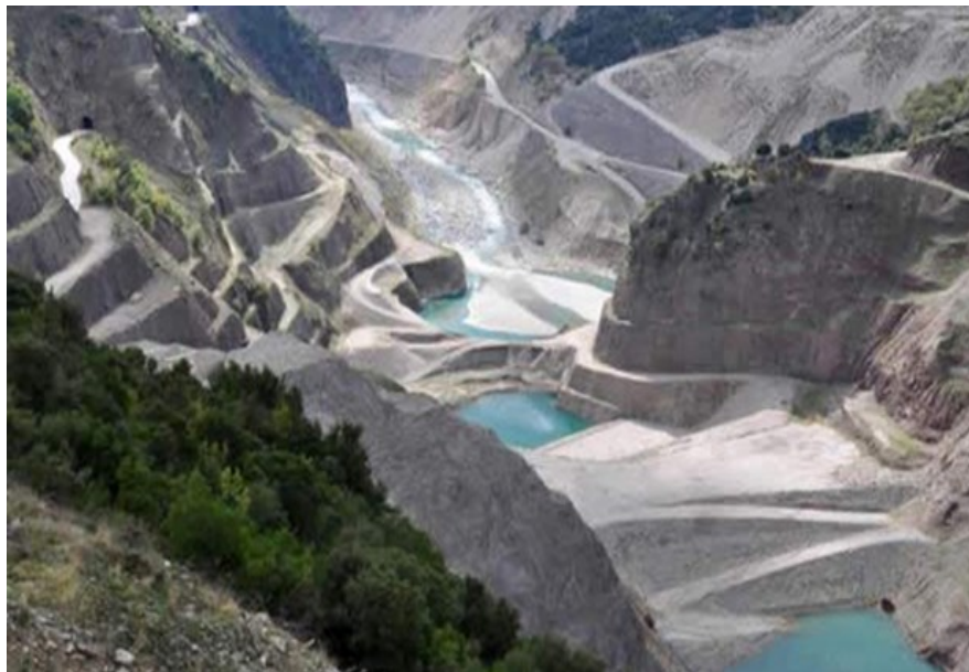
Εικόνα 15: Αρχικό στάδιο κατασκευής
