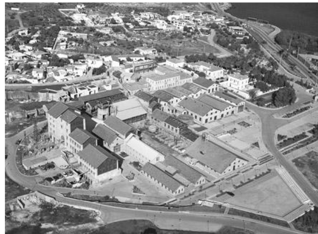
Τεχνολογικό Πάρκο Λαυρίου στο παλιό εργοστάσιο ( www.ltp.ntua.gr )
