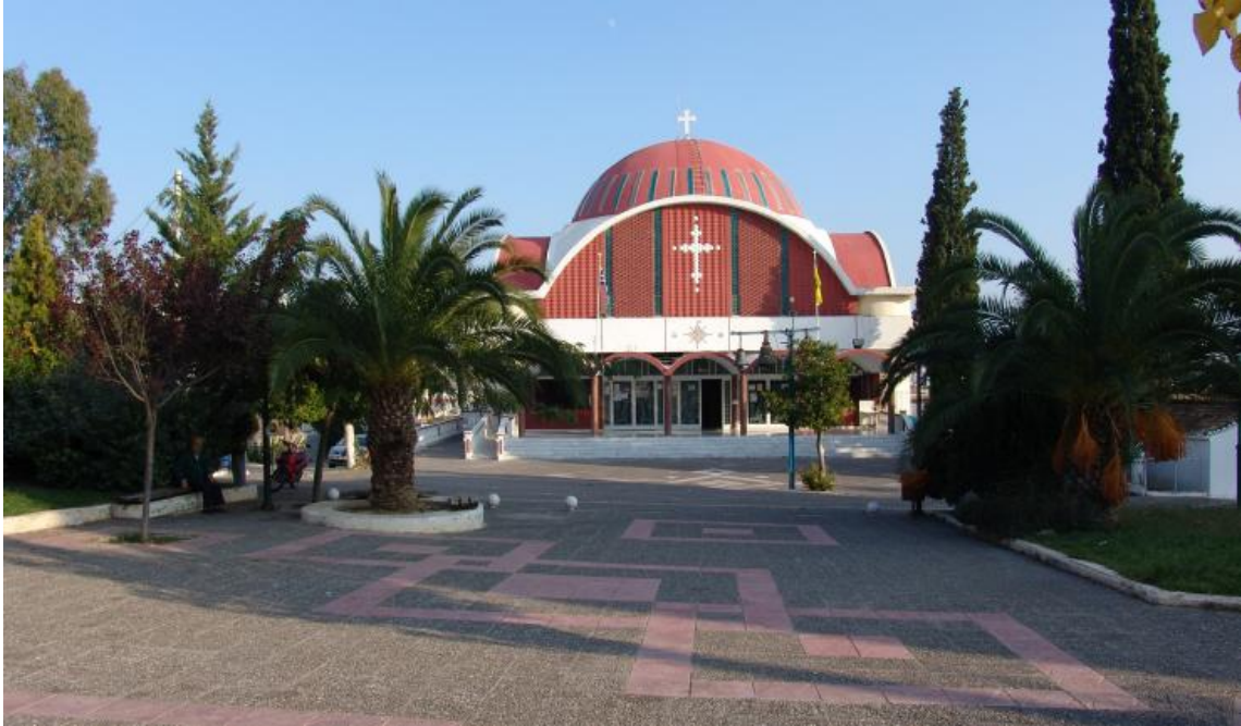
Εικ. 8. Η πλατεία του Αγίου Νικολάου στο Καματερό
