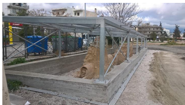
26. Διαμόρφωση προστασίας αρχαίου αγωγού. Φωτογραφικό υλικό εταιρείας Άκτωρ
