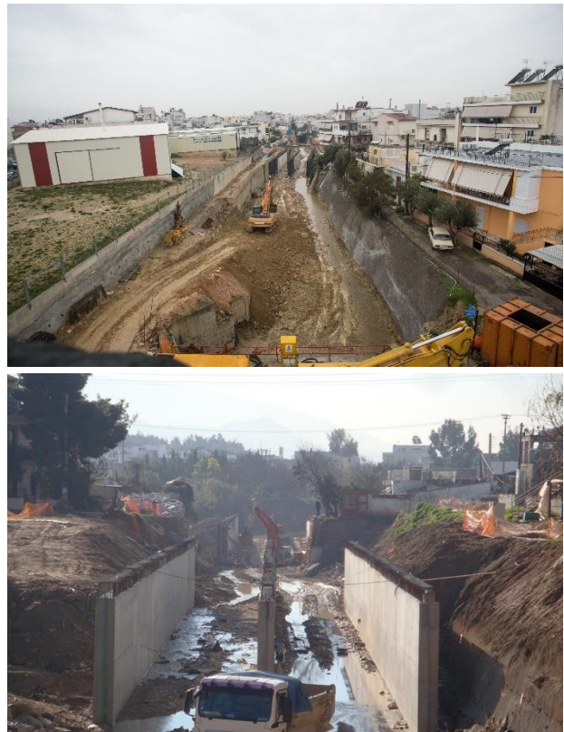
19,20.φωτογραφίες από τα έργα εγκιβωτισμού του ρέματος Εσχατίας τμήματος 1 ο . Πηγή εικόνων : Αρχείο εταιρείας Άκτωρ
