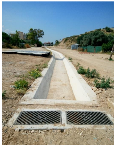
22,23. επιφανειακή τάφρος. Τωρινή κατάσταση περιοχής. Αρχείο εταιρείας Άκτωρ
