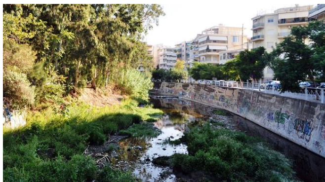
36. η κατασκευή τοίχων από οπλισμένο σκυρόδεμα σε τμήμα του ρέματος
