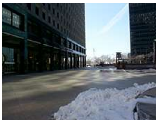
«πλατεία» και στοά στον αρ.1 της New York Plaza.
